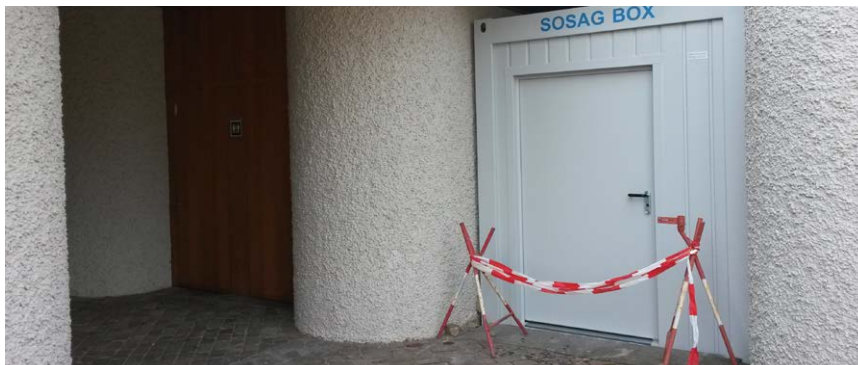
Einbau einer rollstuhlgängigen Toilette im Friedhofgebäude
