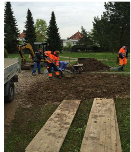
Vorbereitung für das Aufstellen des neuen Brunnens auf dem Friedhof
