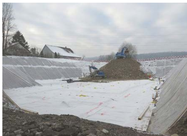
Aushub für den Ergänzungsbau des Alters- und Spitexzentrums
