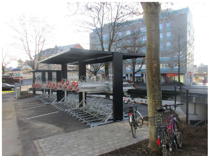
Neue Veloabstellanlage beim Bahnhof Nord
