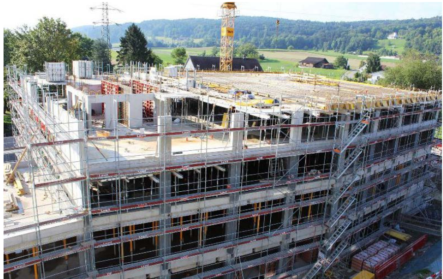
Die Baustelle des Ergänzungsbaus des ASZD
