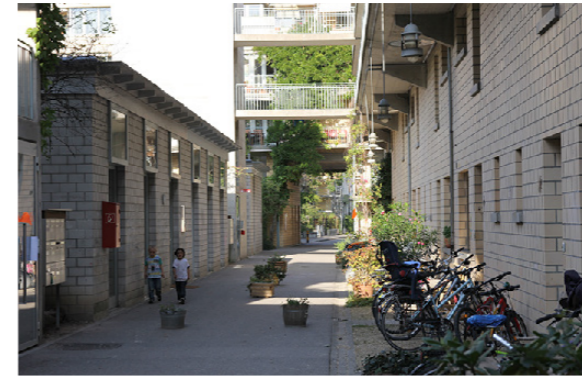
Fussgänger- und kinderfreundliche Binnenerschliessung im Quartier, die gleichzeitig als Aufenthaltsbereich gestaltet wird (erny & schneider AG: Davidsboden Basel)
