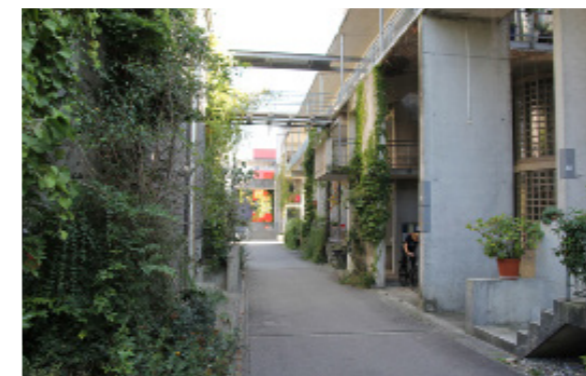
Eingangsbereiche verdichtet (Althaus Architekten: Baumgarten Bern)
