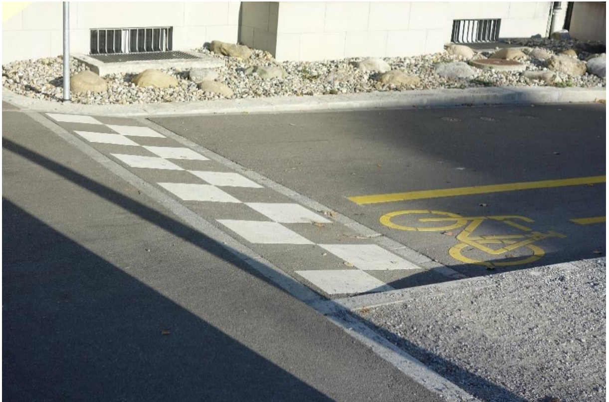
Abbildung 38: Velofreundliche Trottoirüberfahrt (Glatzquai)
