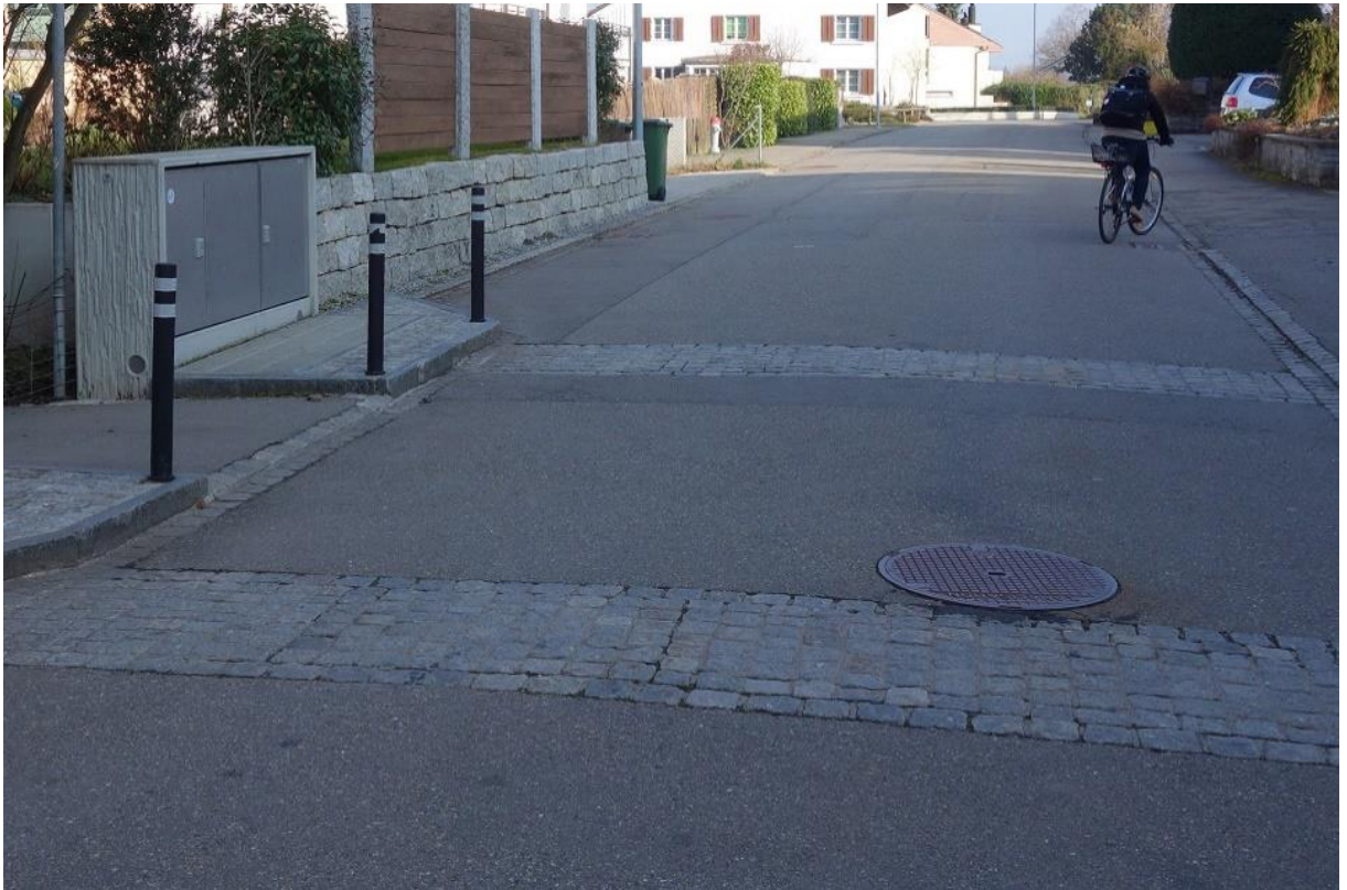
Abbildung 36: Querungshilfe Schulweg (Alte Gfenn-Strasse)
