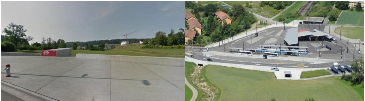
Abbildung 54 Bahnhofplatz Stettbach nach Fertigstellung, Ausblick auf den Zürichberg heute.
