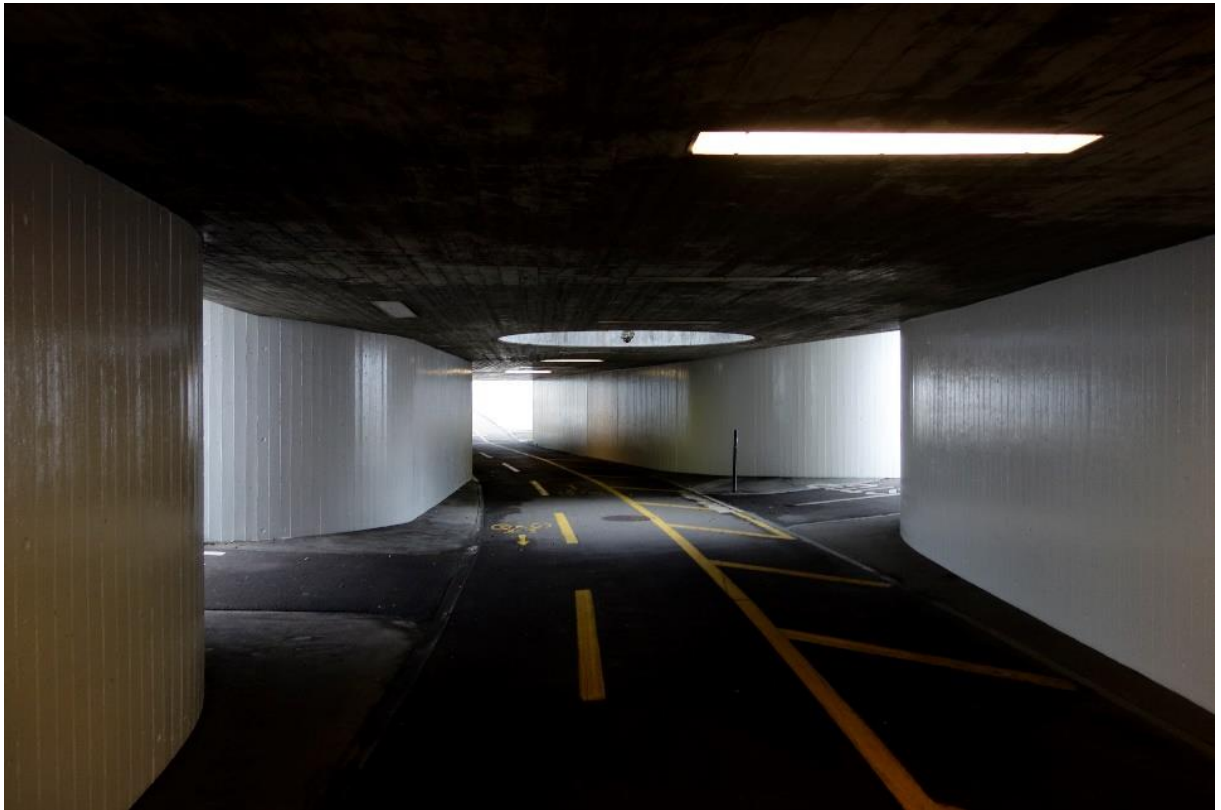
Abbildung 30: Fließende Geometrie und präzise gesetztes Licht macht die Unterführung attraktiv für Fuss-/Veloverkehr (Oskar Bider Strasse)
