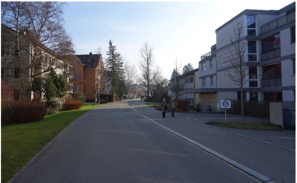
Abbildung 25: Strassen: Sehr gut LV-geeignete Quartierstrasse mit beidseitig schönen Randabschlüssen (Alte Gfenn Strasse)
