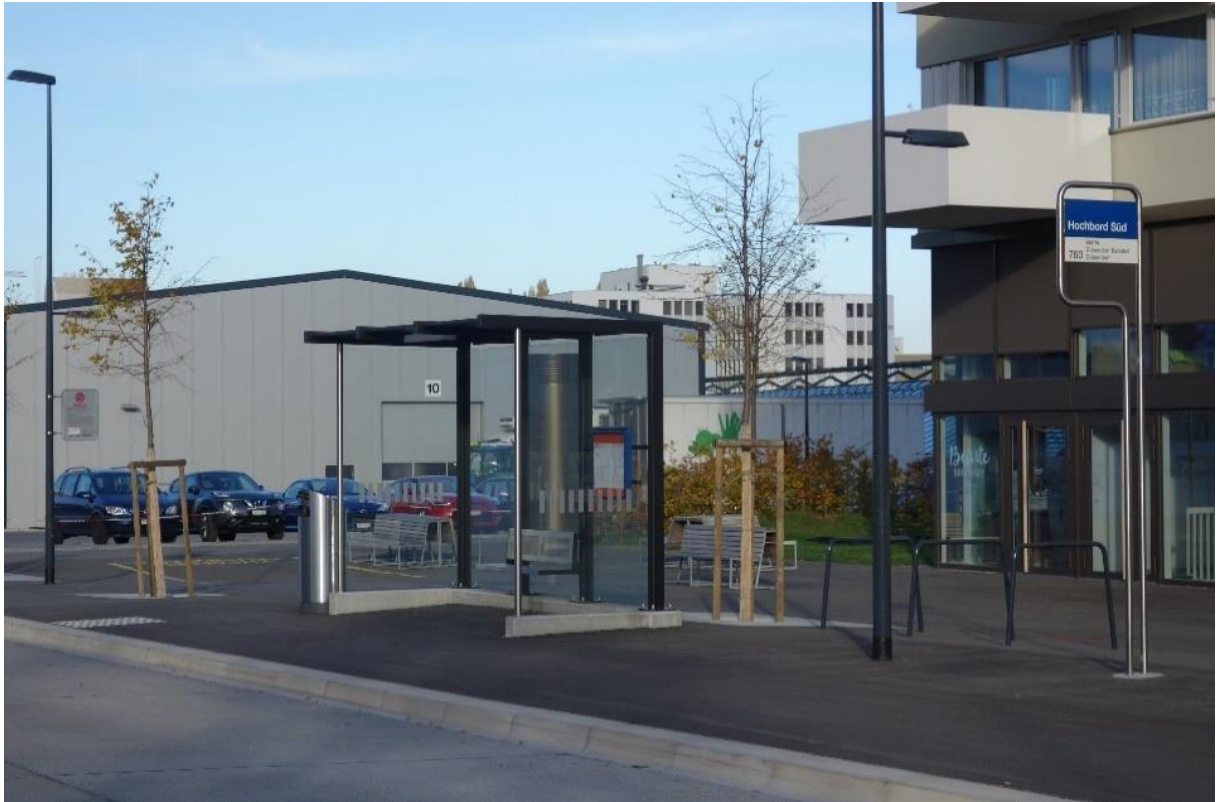
Abbildung 43: Bushaltestelle. Haltekante in Beton (Hochbordstrasse)
