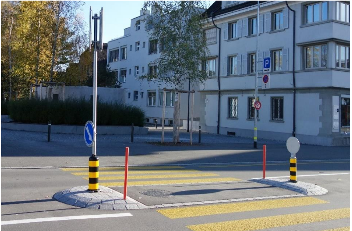
Abbildung 39: Querungshilfe für Fussgänger (Bahnhofstrasse)
