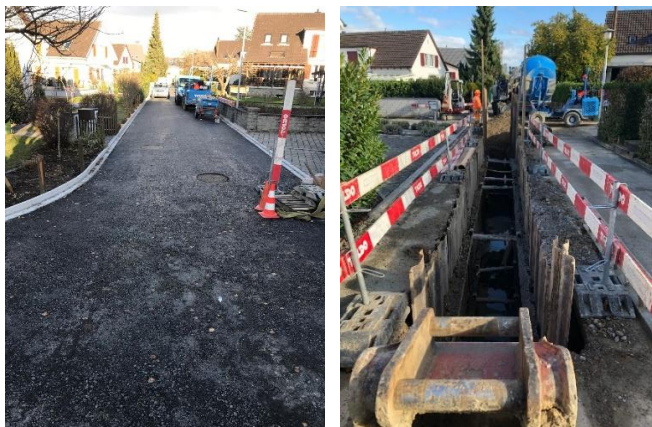
Legende: Bauarbeiten Tödistrasse
