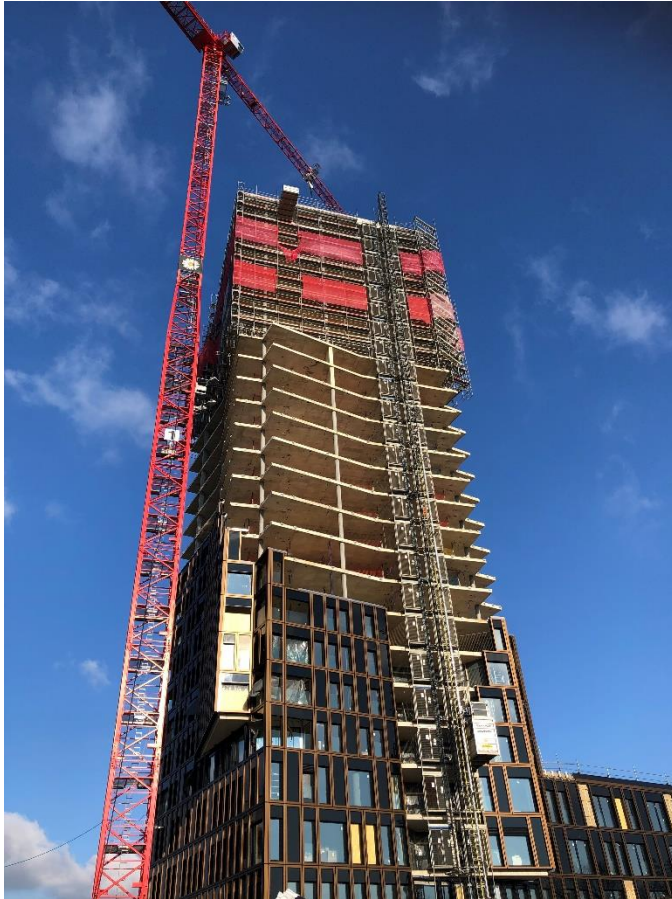
Legende: Hochhaus «Giessenturm» im Bau
