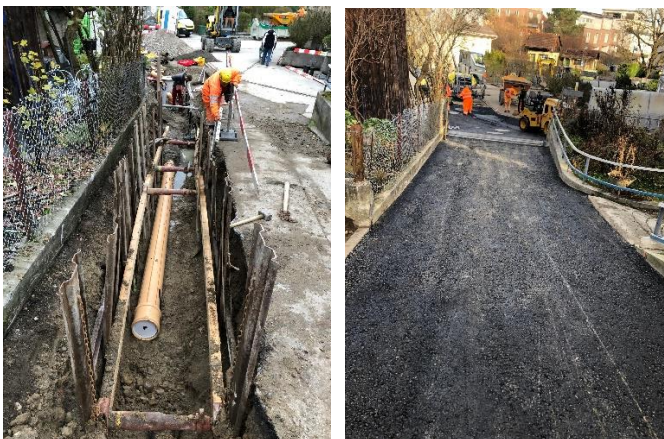
Legende: Bauarbeiten Stettbachstrasse
