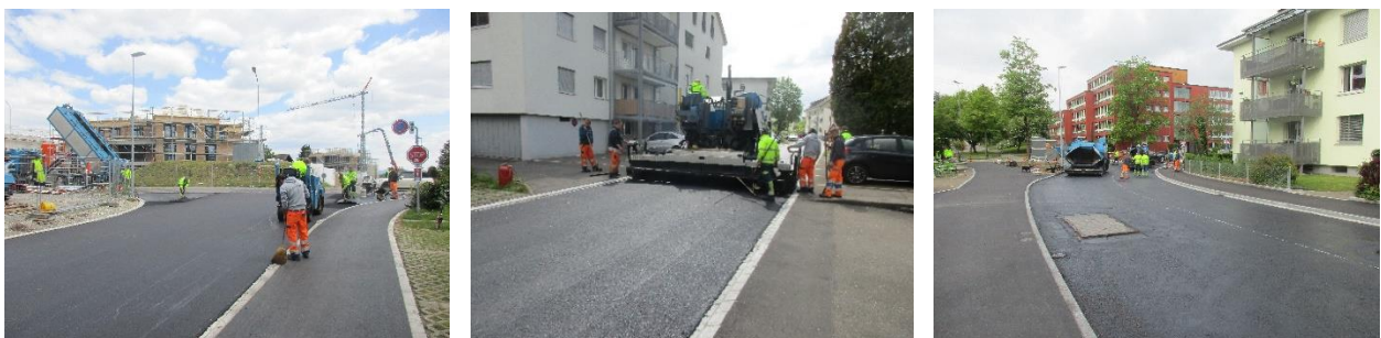
Legende: Bauarbeiten Oberdorfstrasse
