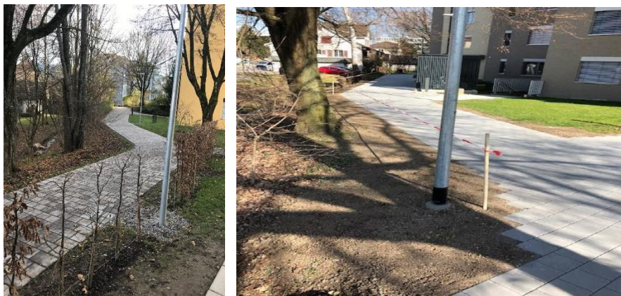
Legende: Bauarbeiten Zipartenstrasse
