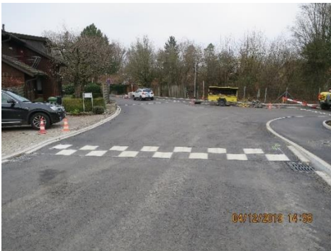
Legende: Bauarbeiten Im Tobelacker
