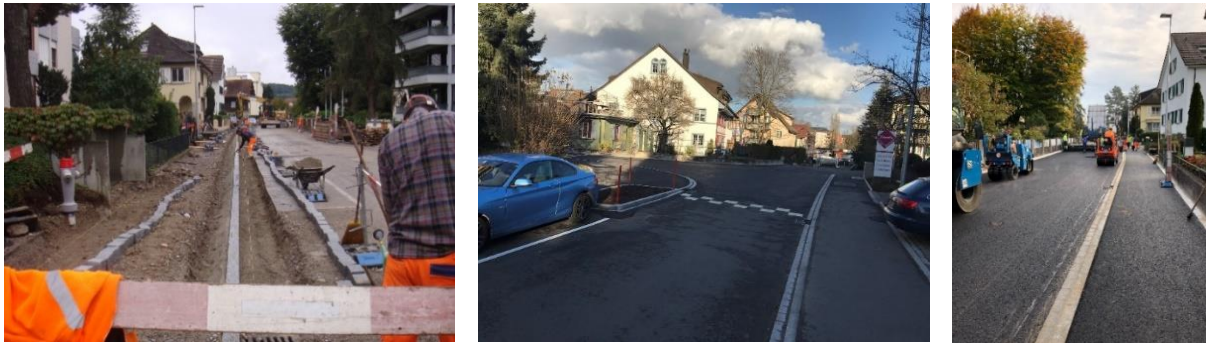
Legende: Bauarbeiten Neuhausstrasse
