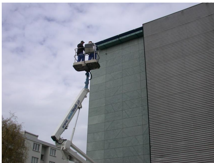
Montage der neuen Mauersegler-Nistkästen an der Wand des Stadthauses
