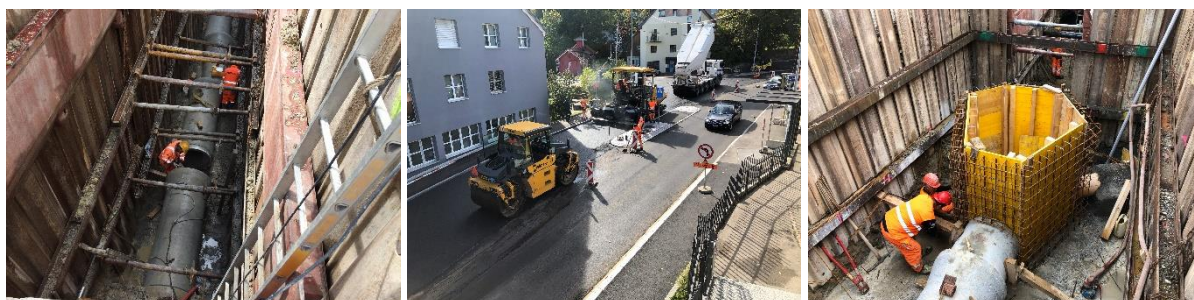
Kanalisations-, Belags- und Ortsbetonbau
