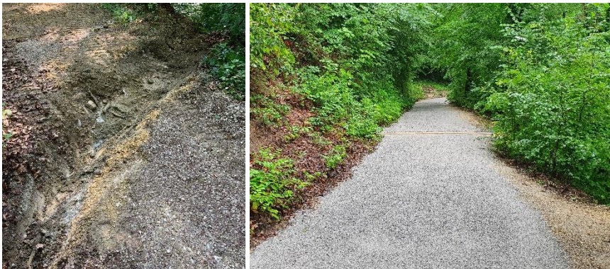
Lättenweg vor und nach der Instandstellung durch den Bereich Unterhaltsdienst
