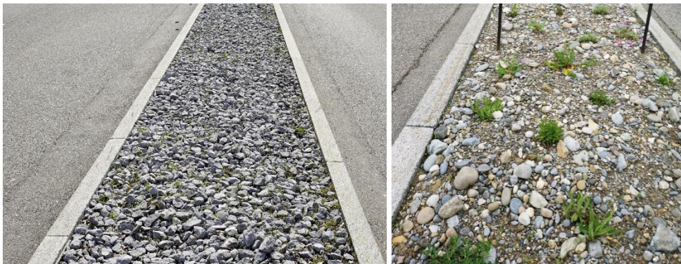
Schotterfläche vor und nach der Anpflanzung
