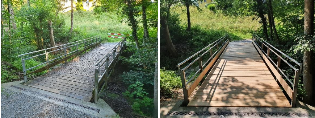
Brücke beim Ratzenhaldenbach in Gockhausen vor und nach der Sanierung
