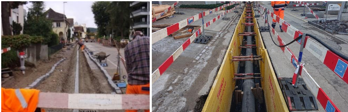
Pflasterungs-, Wasserleitungs- und Kanalisationsbau
