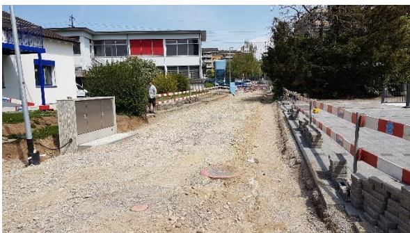
Strassenfundation und Verteilkabine für Strom
