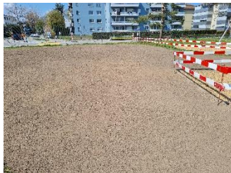
vor dem verlegen
