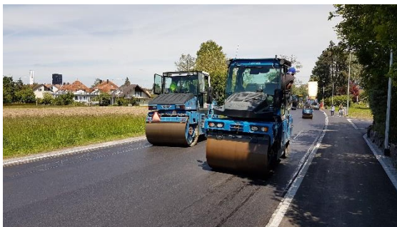
Deckbelagsverdichtung mit Walzen
