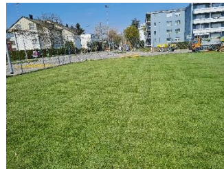
600 m 2 Rollrasen verlegt
