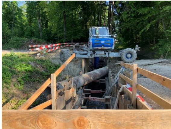
Kanalanschluss bei Rohrende Seite Wallisellen
