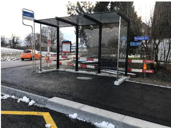
Neue Haltestelle Raubbühlstrasse Süd
