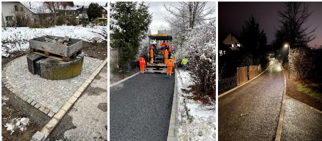
Pflasterung-und Belagsbau sowie Beleuchtung
