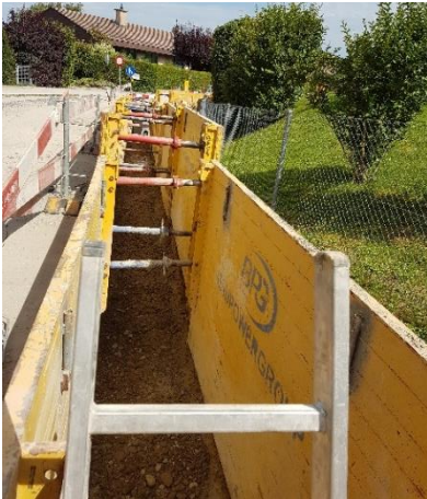
Gespriesster Graben für neue Kanalisation
