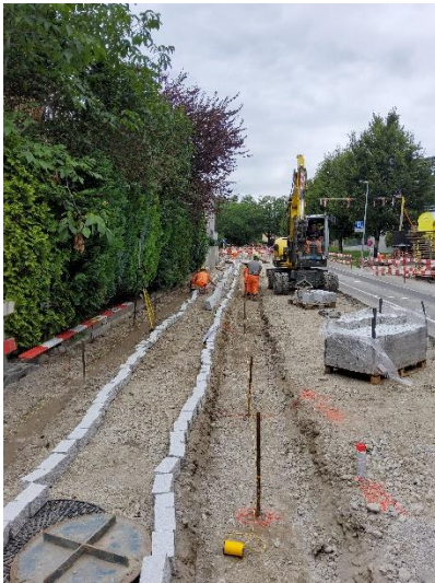
Absteckung für Randabschlüsse
