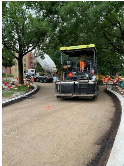
Planie und Tragschichteinbau mit Fertiger
