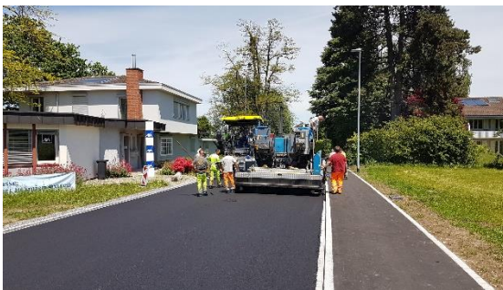
Deckbelageeinbau mit Einbaumaschine (Fertiger)
