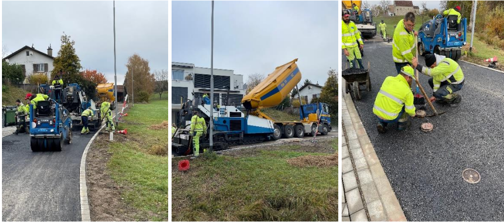
Einbau Tragschicht
