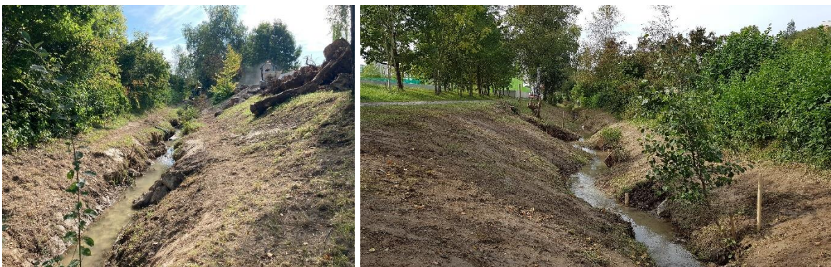
Sagentobelbach während und nach der Fertigstellung der Unterhaltmassnahmen
