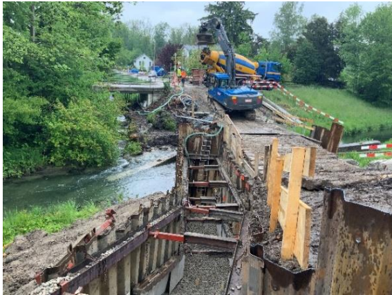
Querung des Chriesbaches mit einem Düker
