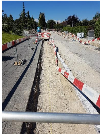
Absteckung für Randabschlüsse und Strassenfundation
