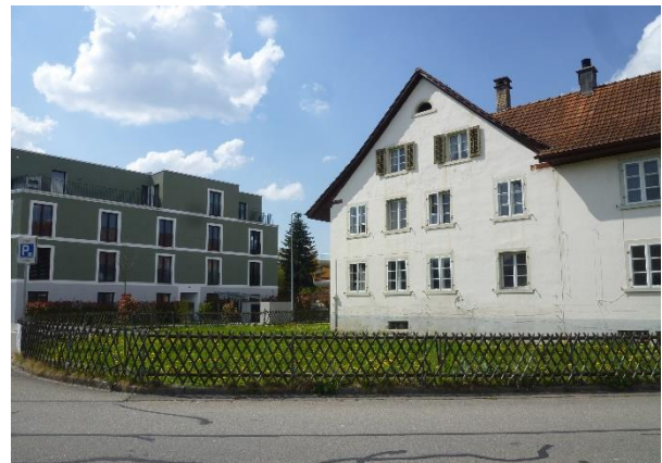
Abbildung 132: historisch wertvolles Gebäude Grundstück Nr. 11706 (Südseite)
