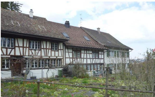
Abbildung 43: Ortstypische Dach-, Fassaden- und Umgebungsgestaltung in der Kernzone Dübelstein
