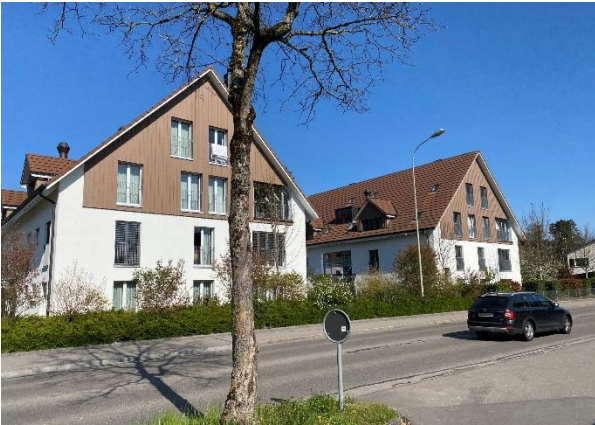
Abbildung 45: Ortstypische Dachgestaltung in der Kernzone Wil mit Satteldach und untergeordneten Dachgauben
