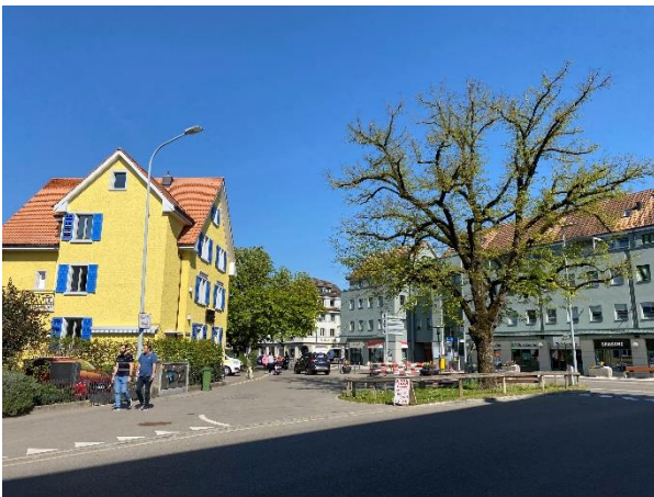
Abbildung 41: Nicht rot bezeichnete Gebäude mit raumprägenden, ortstypischen Fassadenfronten beim Lindenplatz
