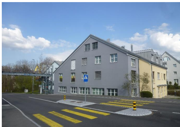
Abbildung 48: Wichtige, senkrecht zur Strassen liegende Firstrichtung im Dorfkern von Gockhausen
