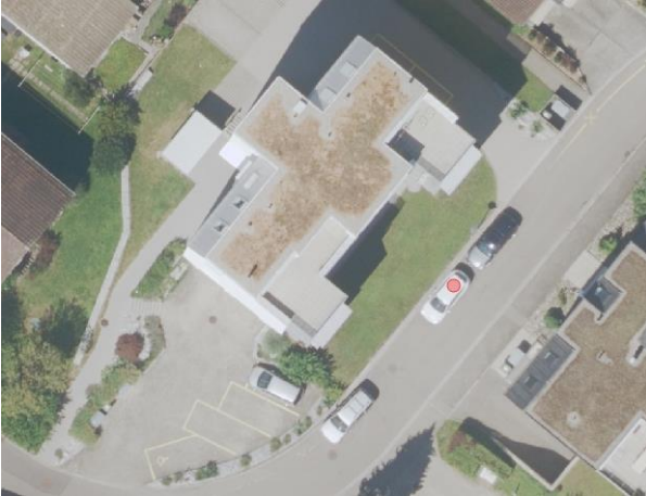
Abbildung 64: Flächige, asphaltierte Abstellflächen und Zufahrten (keine Aussenraumqualität)
