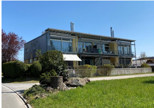
Abbildung 46: Eher für Kernzonen und Weiler untypische Flachdachbaute
