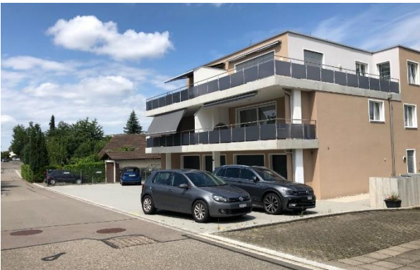
Abbildung 66: Fehlende Grünraumfläche entlang des öffentlichen Raums
