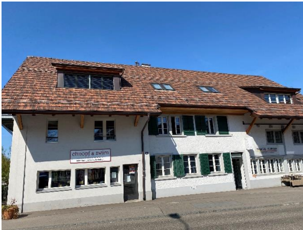
Abbildung 49: Ortstypische, ruhige Dachfläche mit untergeordneten Schleppegauben und Dachflächenfenstern
