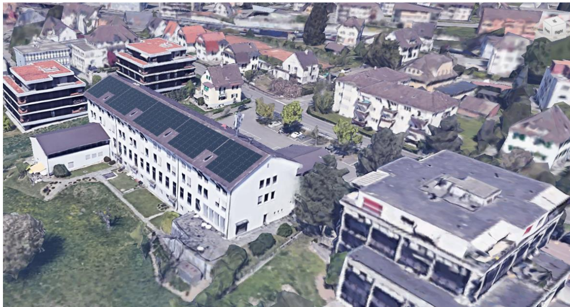
Abbildung 10: Übersicht über die geplante Solarstromanlage auf der städtischen Liegenschaft in welcher sich die Bibliothek, Sozialamt und Stiftung WBK befindet (Bildquelle: Google Maps).
