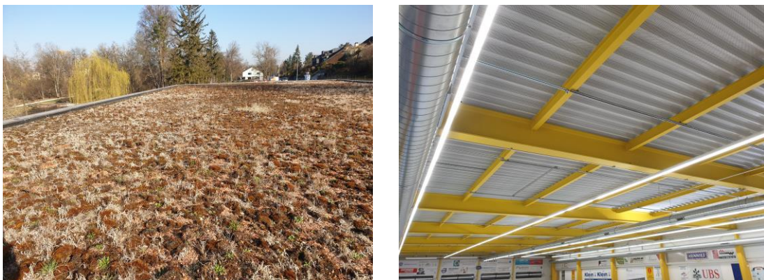
Abbildung 7: links: Übersichtsbilder der Dachflächen, rechts Ansicht Tragkonstruktion Dach Curlinghalle
