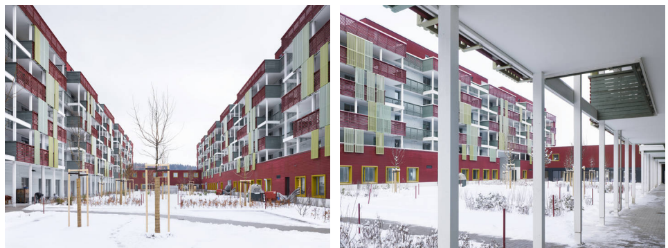
Abb. 10: Mehrgenerationenhaus "Giesserei", Winterthur (Quelle: www.galli-rudolf.ch , Galli Rudolf Architekten AG)
