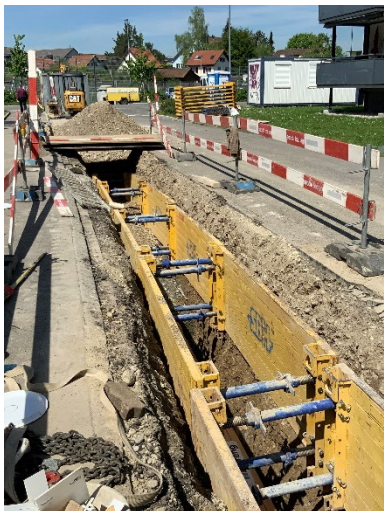
Gespriesster Graben für die Kanalisation
