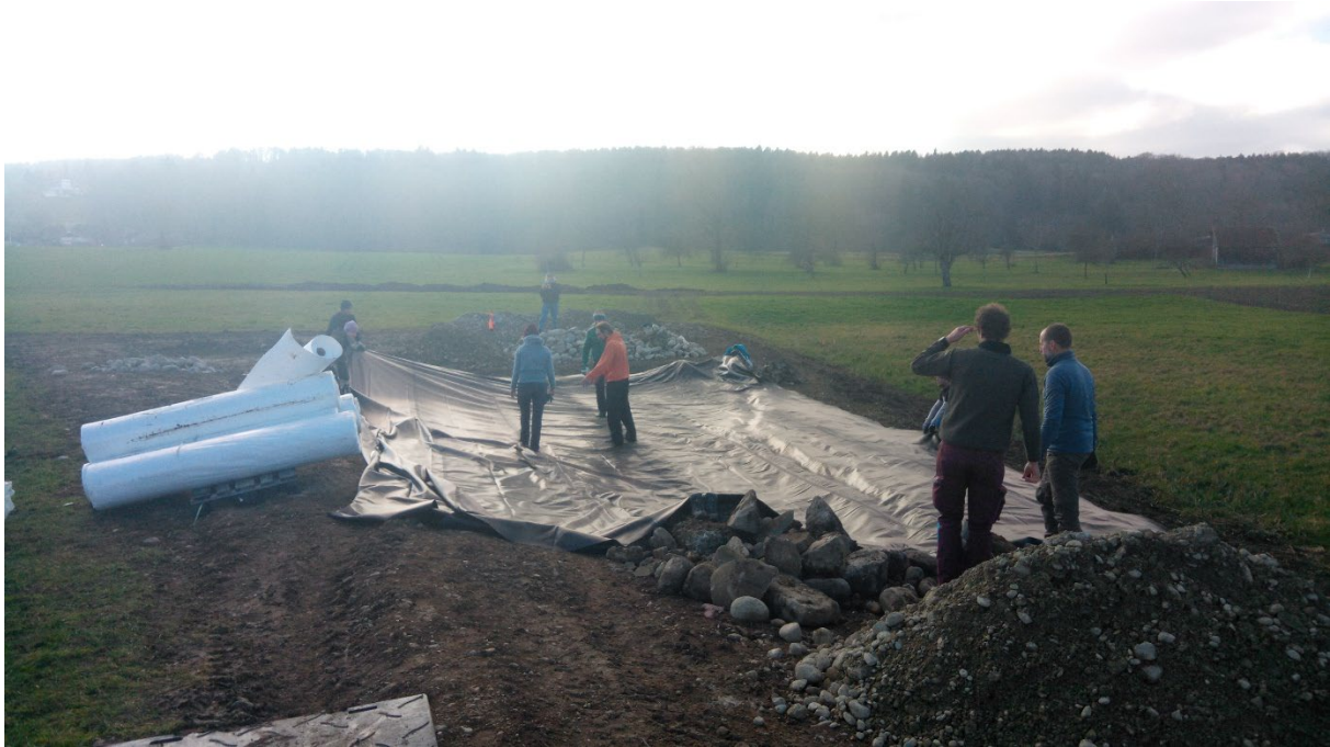
Aufwertungsprojekt Chürzi/Seewadel während dem Bau im Februar 2023
