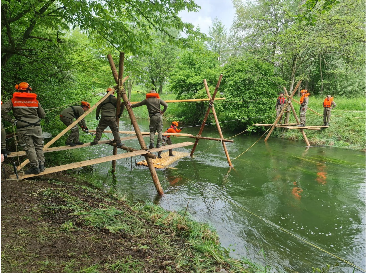
Zivilschutz-Pioniere der Technischen Hilfe beim Erstellen einer Behelfsbrücke über die Glatt
