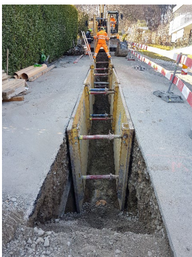
Werkleitungsgraben gespriesst
