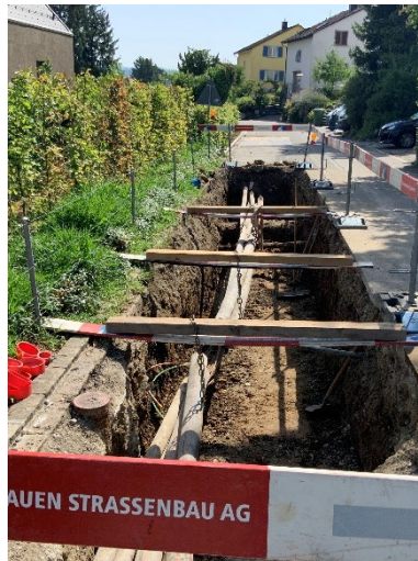
Grabenbau für Elektrorohre
