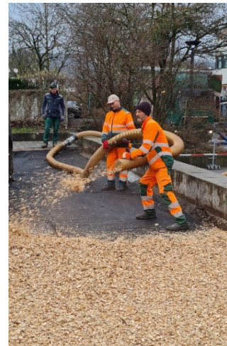
Einbau Holzschnitzel als Fallschutz
