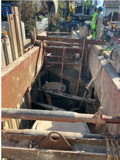
Gespriesster Graben für Kanalisation
