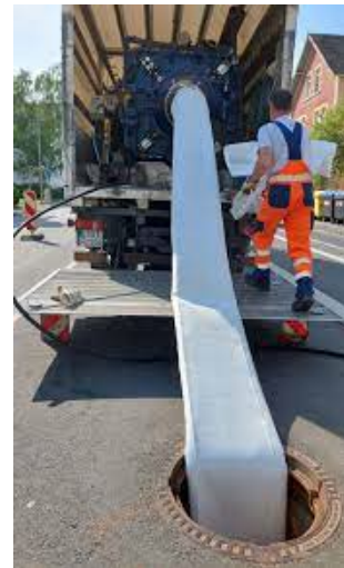
Einzug von Schlauch (Inliner)
