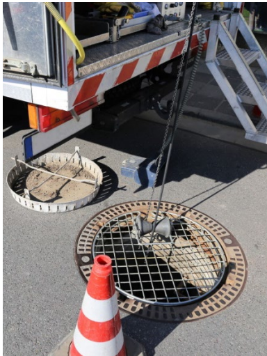
Installation für Kanal-TV Aufnahmen
