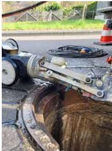
Roboter für Innensanierung
