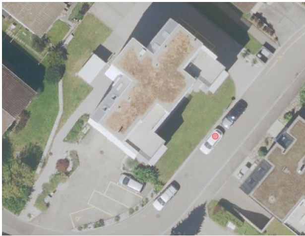
Abbildung 74: Flächige, asphaltierte Abstellflächen und Zufahrten (keine Aussenraumqualität)
