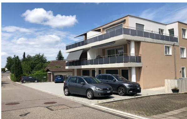
Abbildung 76: Fehlende Grünraumfläche entlang des öffentlichen Raums
