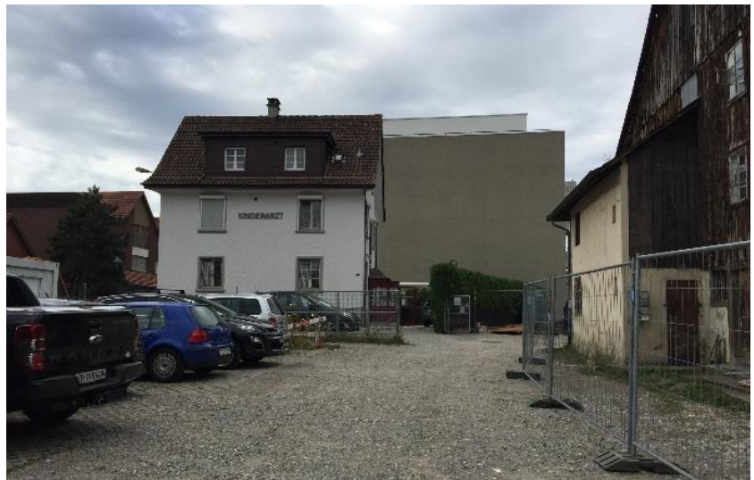
Abbildung 171: Gebäude auf dem Grundstück Nr. 13933 und hinterliegender Flachdachbaute
