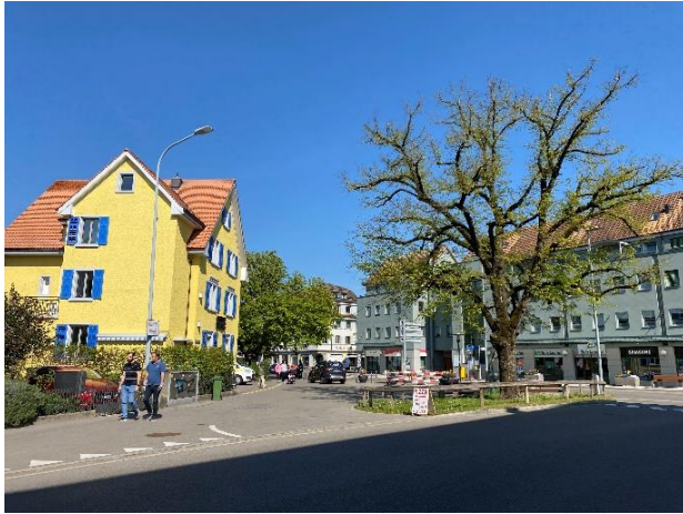
Abbildung 42: Nicht rot bezeichnete Gebäude mit raumprägenden, ortstypischen Fassadenfronten beim Lindenplatz
