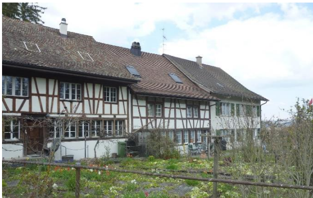
Abbildung 44: Ortstypische Dach-, Fassaden- und Umgebungsgestaltung in der Kernzone Dübelsein
