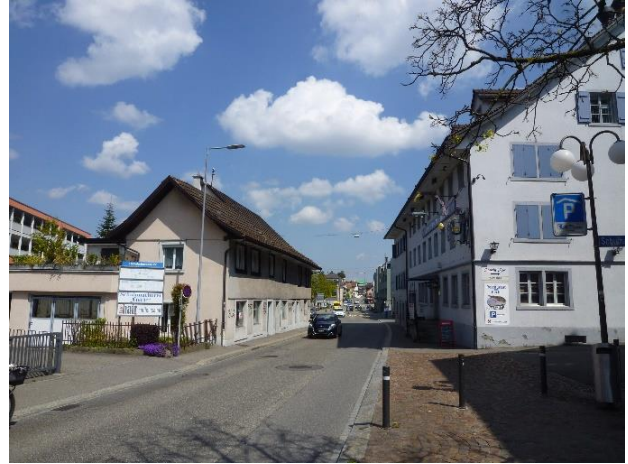
Abbildung 41: Rot bezeichnete Gebäude Kernzone Bahnhofstr.
