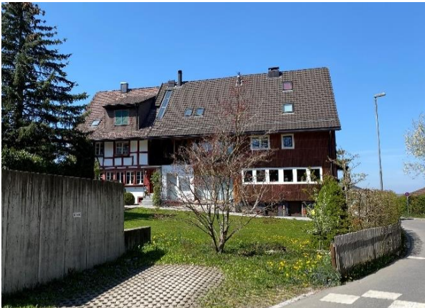
Abbildung 56: Unbebauter, grüner Aussenraum mit Sicht auf ortstypische Baute in Gockhausen
