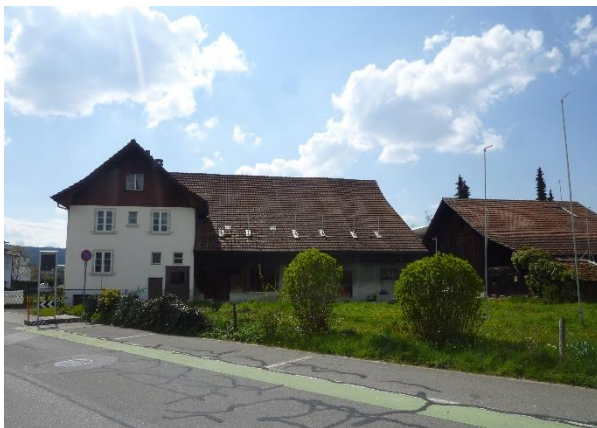
Abbildung 193: historisch wertvolles Gebäude Grundstück Nr. 11706 (Nordseite)
