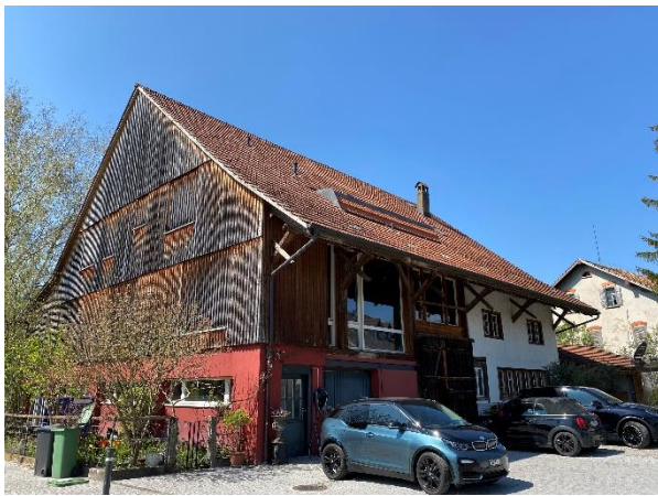
Abbildung 58: Zeitgemässe, sanfte Integration grosser Fensterflächen in historischem Gebäude
