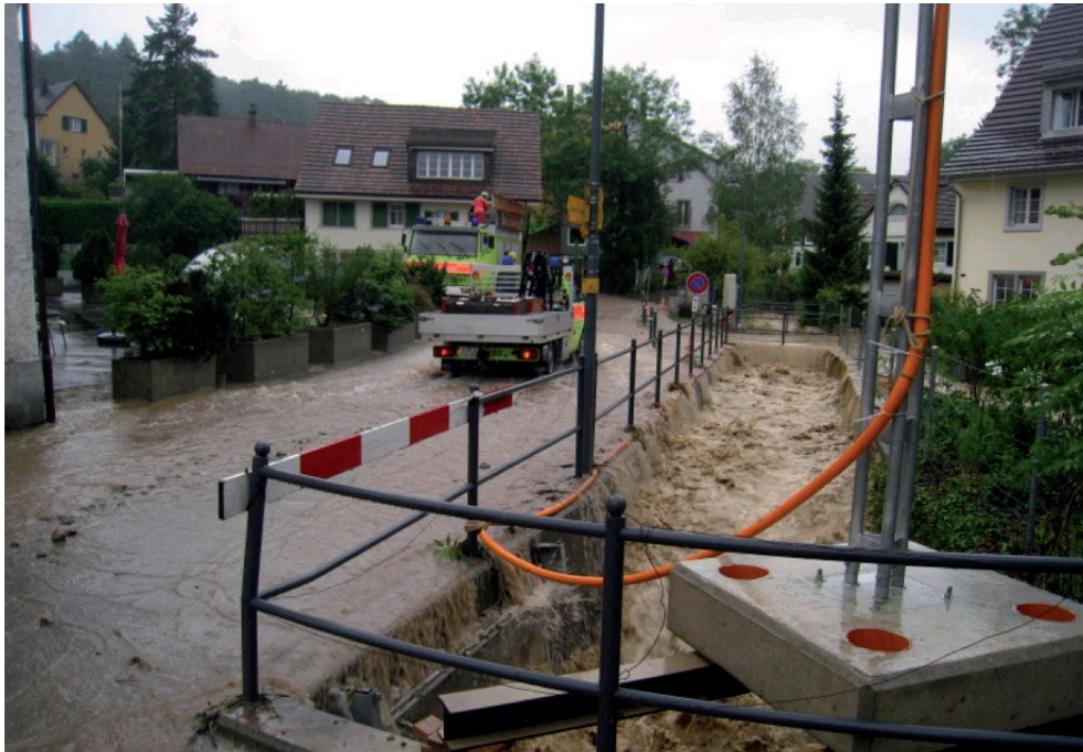
Hochwasser vom 3. Juli 2012 am Sagentobelbach in Stettbach (Foto: Gossweiler Ingenieure AG)
