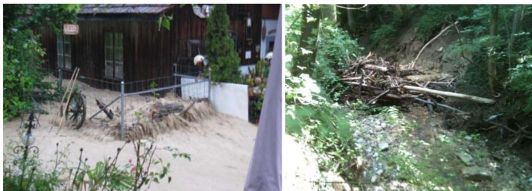
**Abb. 3:** links: Verklauste und überströmte Brücke an der Stettbacherstrasse 50 am 03.07.2012. Rechts verklauster Fliessquerschnitt im Tobel nach dem gleichen Ereignis (5).
