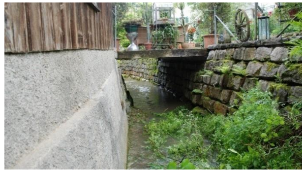
Kilometrierung 1850, Brücke Stettbachstrasse 50, stromabwärts
