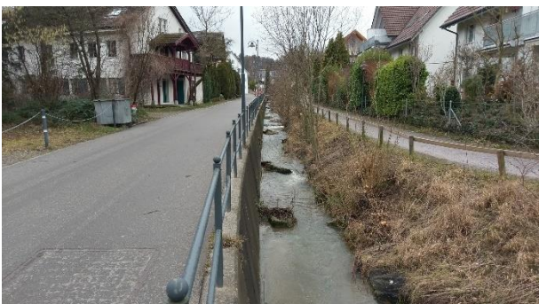
Kilometrierung 1700, Stettbachstrasse, stromaufwärts
