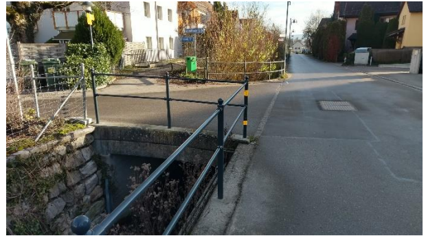
Kilometrierung 1790, Brücke Böszelgstrasse
