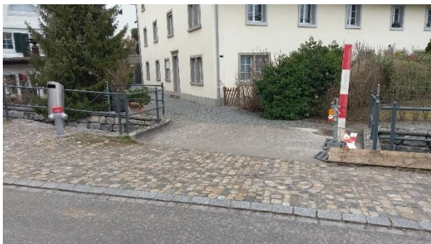
Kilometrierung 1820, Brücke Stettbachstrasse 50
