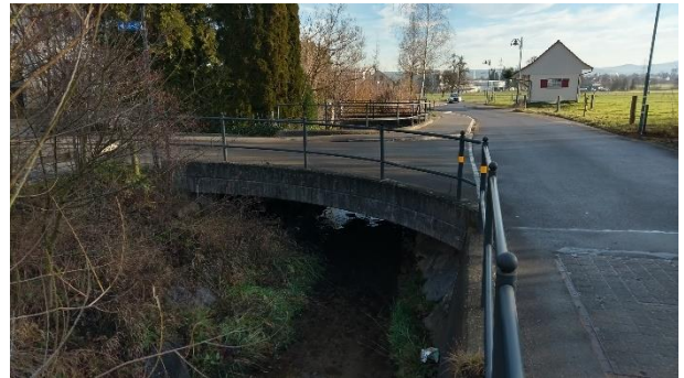
Kilometrierung 1675, Brücke, stromabwärts
