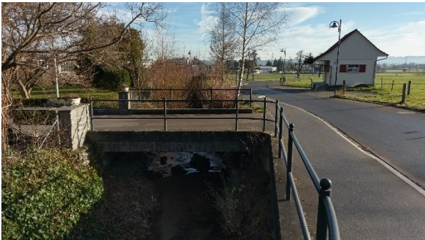
Kilometrierung 1655, Brücke, stromabwärts
