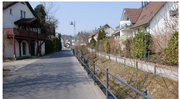
Kilometrierung 1700, Stettbachstrasse, stromaufwärts
