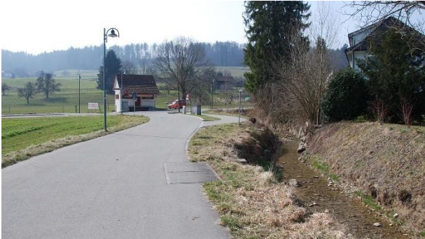
Kilometrierung 1580, Sagentobelbachweg, stromaufwärts
