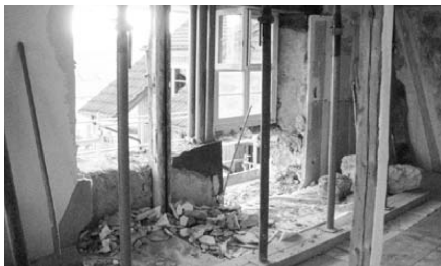
Klosterstrasse 6 während des Umbaus
