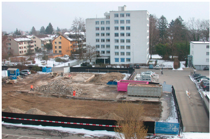
Abbruch auf dem Leepünt-Areal
