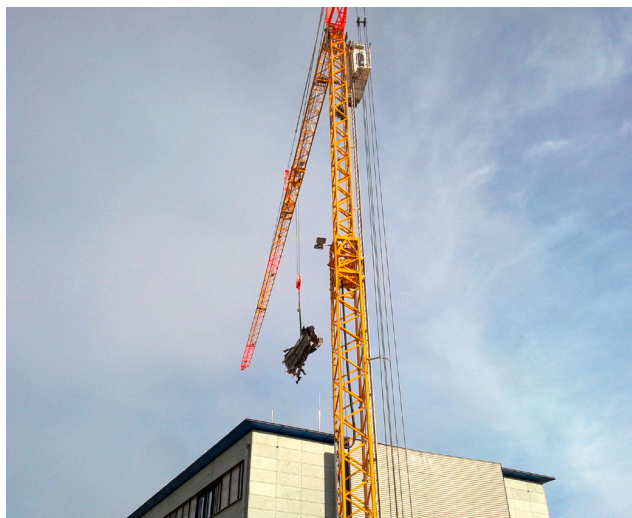
Sanierungsarbeiten am Bogendach
