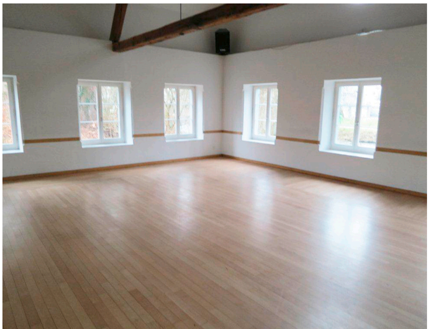
Innenarbeiten in der Senfmühle
