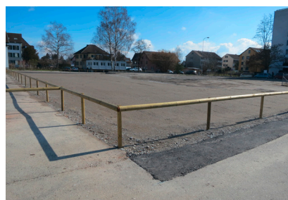
Planierte Fläche nach dem Rückbau
