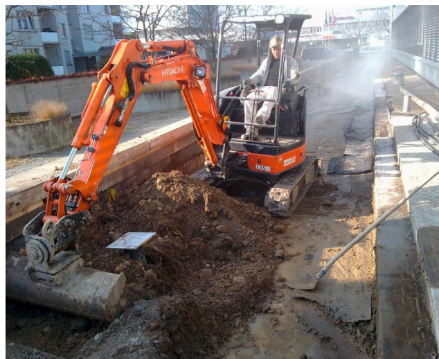
Aushubarbeiten für das Retentionsbecken mit schwerem Gerät
