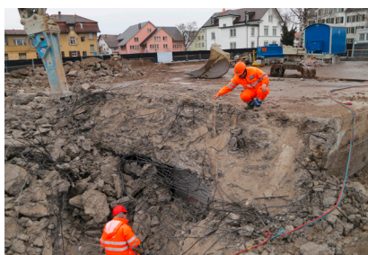
Dicker, harter Beton beim Kommandoposten
