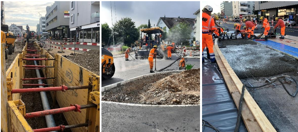
Werkleitungs-, Belags- und Betonarbeiten
