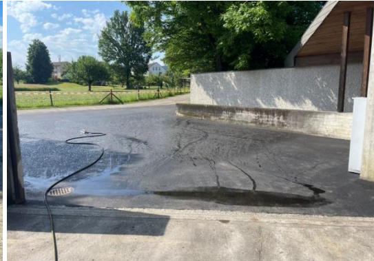
Der fertiggestellte Vorplatz
