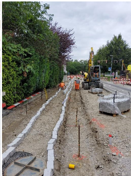
Absteckung für Randabschlüsse und Strassenfundation
