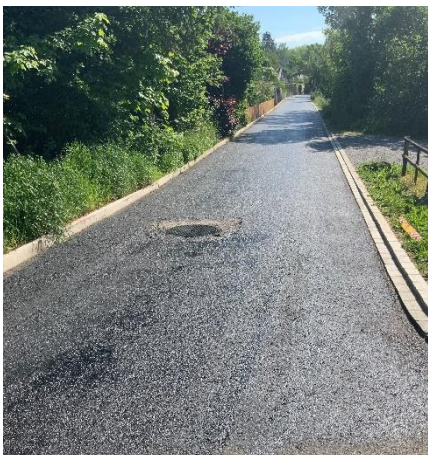
Strasse entlang Chriesbach
