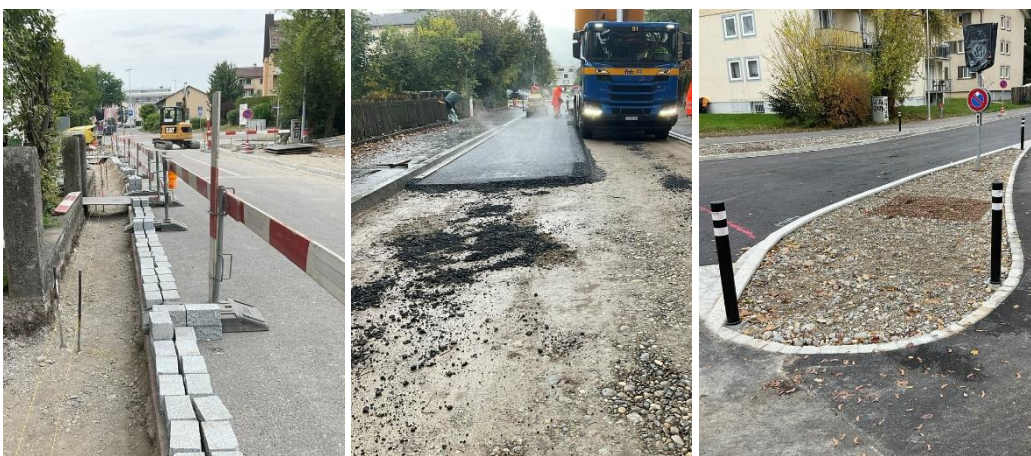
Pflästerung- und Belagsarbeiten sowie neu geschaffene Baumgruben
