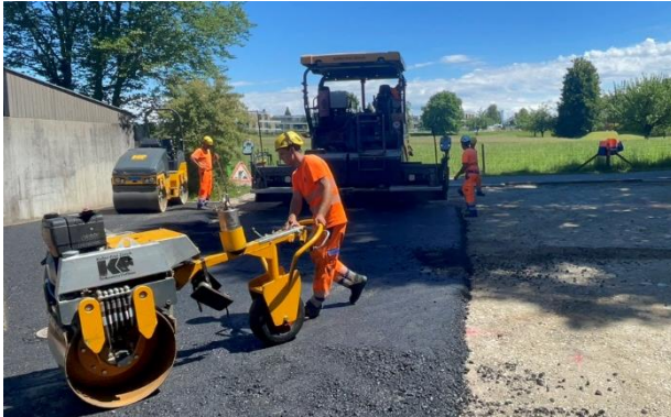
Der Vorplatz während dem Einsetzen des Belags
