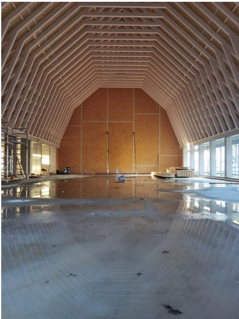
Grosser Saal des Neubaus "Speicher" bei der Oberen Mühle im Rohbau
