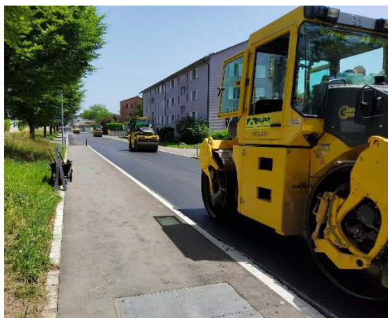
Belagsverdichtung mit Walzen
