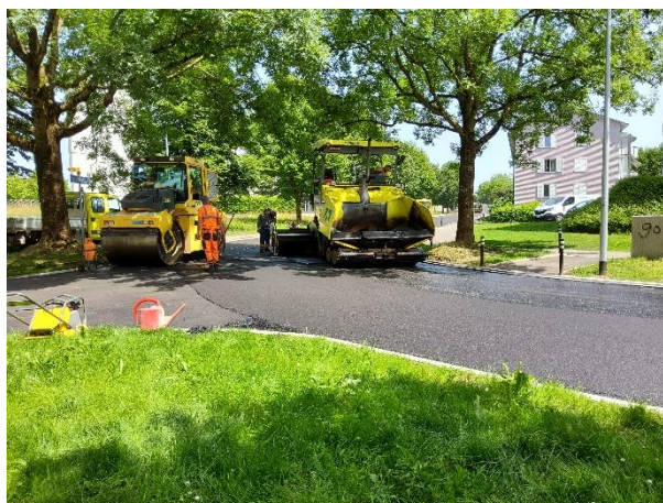
Deckbelageeinbau mit Einbaumaschine (Fertiger)
