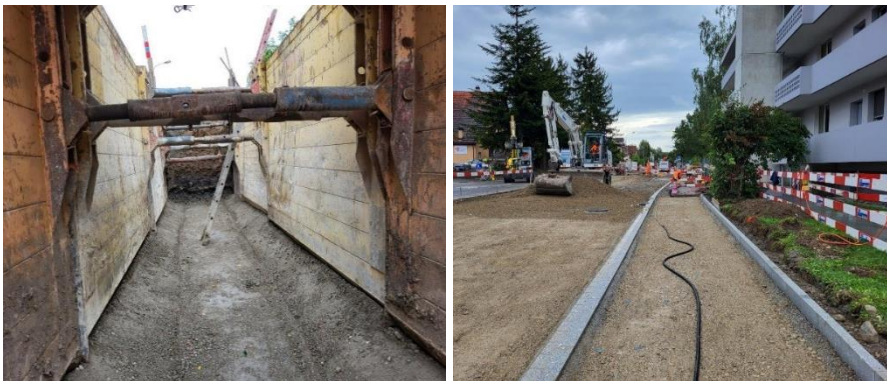
Grabenspriessung für Kanalisation
