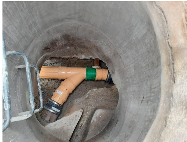
Sanierung von Schachtsohle
