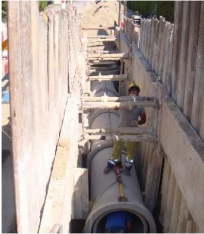
Grabenbau für Kanalisation
