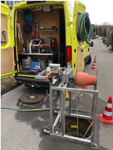
Installation für Inliner
